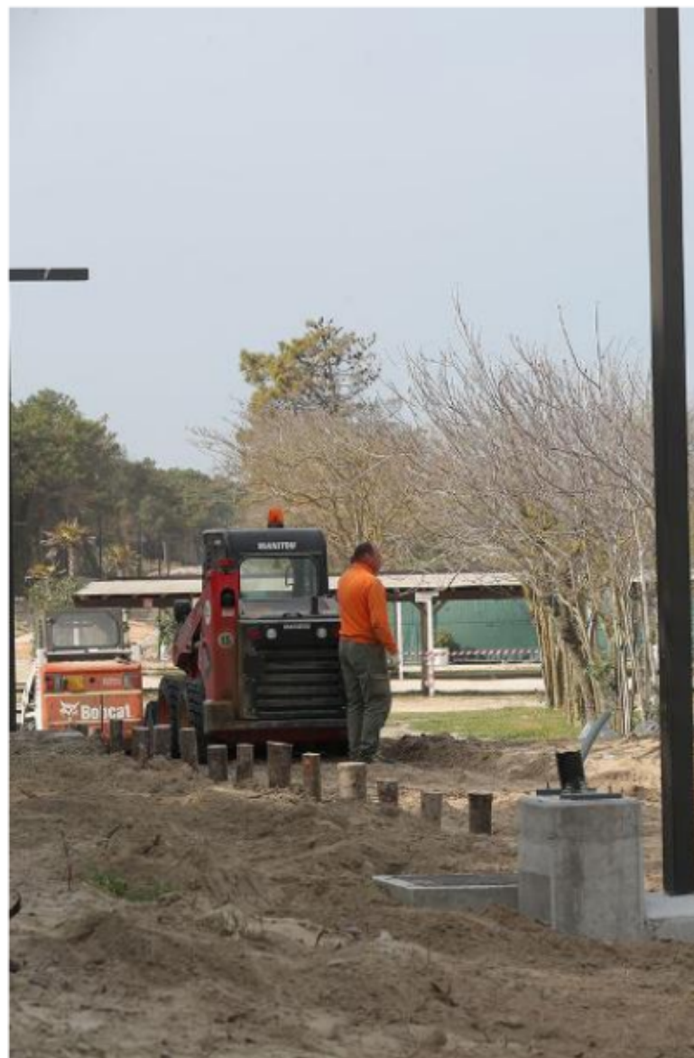
Parco marittimo, il cantiere quest'estate a Marina di Ravenna (Zani)
